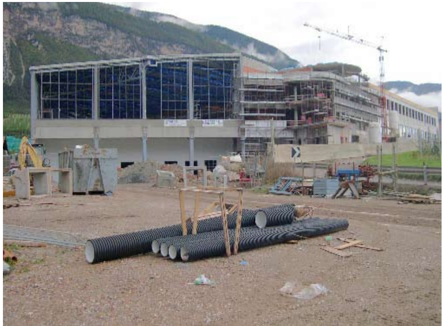
Centro di Confezionamento Contà a Cunevo in fase di ampliamento
