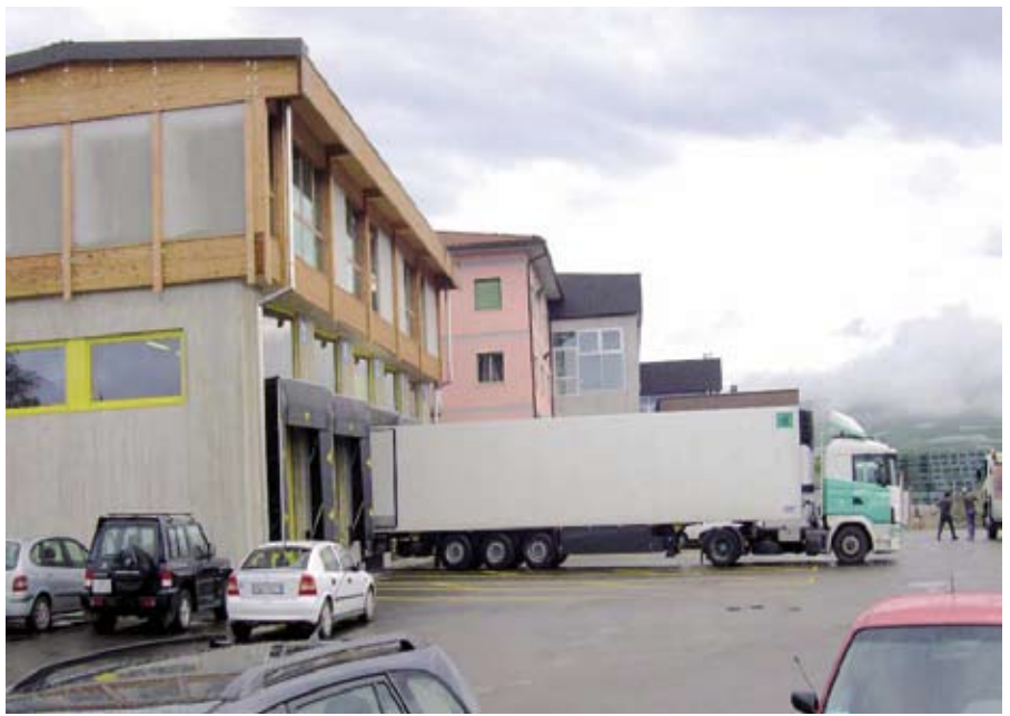
Nuova piattaforma di carico Centro di Confezionamento Terza Sponda Revò
